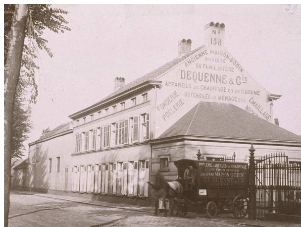
L'usine de Laeken
